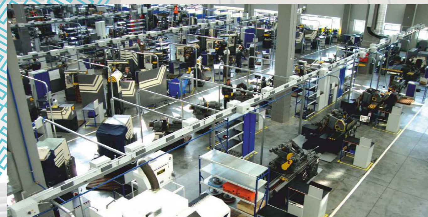
АО «Концерн «Калашников» Распределительные и магистральные шинопроводы от 400А до 2500А
