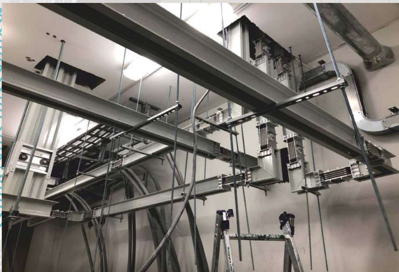
ЛОТТЕ Отель, г. Самара Распределительные и магистральные шинопроводы 400А, 630А, 1000А, 2500А
